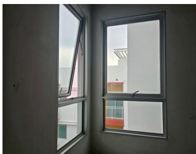
ช่องระบายอากาศบันไดหนีไฟ
