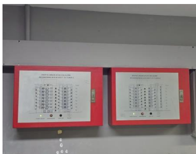
แผงควบคุมแจ้งเหตุเพลิงไหม้
